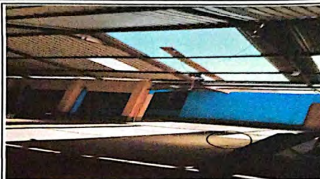
Foto 2: Sustitución de laminas del techo.
