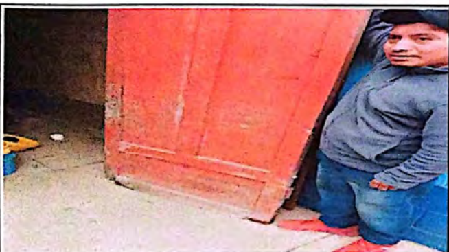
Foto 3: Sustitución de Puerta de Bodega.
