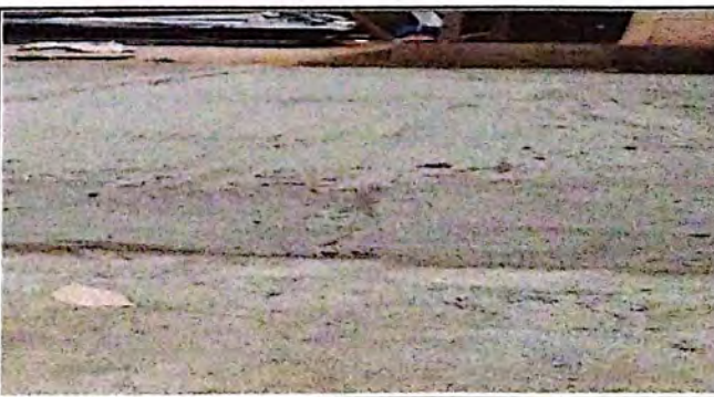
Foto 6: Sustitución de piso en torta de concreto
