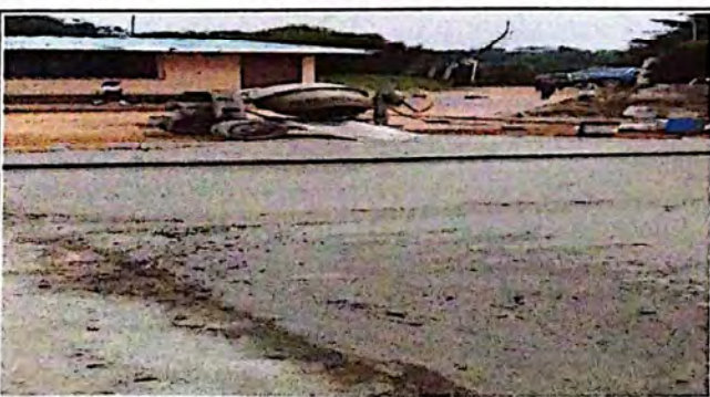
Foto 5: Sustitución de piso en torta de concreto.
