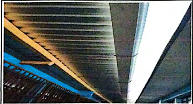
Foto 8: Sustitución de canales y bajadas de agua.
