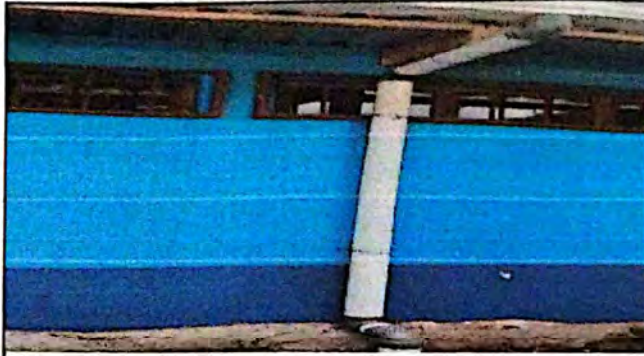
Foto 7: Sustitución de canales y bajadas de agua.
